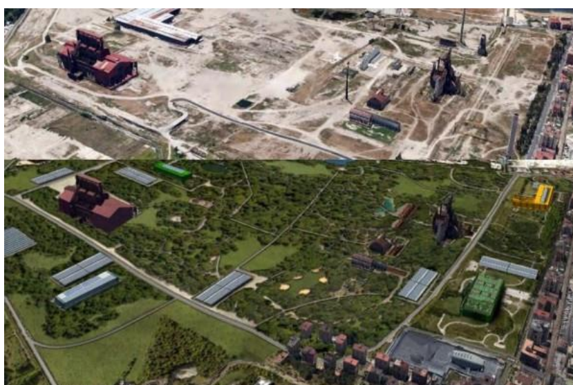
La Porta del Parco. Fonte: https://www.vesuviolive.it/ultime-notizie/143651-novita-progetto-bagnoli-al-via-le-gare-dappalto-per-la-bonifica/
