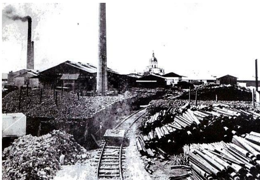
Le Acciaierie Ferriere Pugliesi di Giovinazzo, Bari. Fonte: https://www.pugliareporter.com/2018/06/29/giovinazzo-spiaggia-nera-acciaio-acciaiera-ferro-scarichi-abusivi-bonifica-2018-1933/
