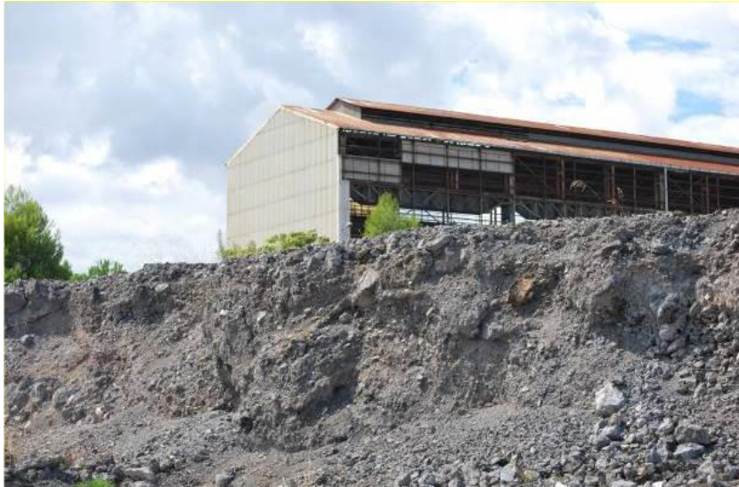
Vista del terrapieno di materiale abbancato - Bonifica in area Lama Castello, ex Acciaierie Ferriere Pugliesi. Fonte: Comune di Giovinazzo, Settore Urbanistica e Ambiente, Bonifica e ripristino ambientale delle "Ex Acciaierie e Ferriere Pugliesi" in area Lama Castello Fase 3: Messa in Sicurezza di Emergenza area Lama Castello - Lotto II - Progetto esecutivo, Relazione tecnica , Gennaio 2016, file:///C:/Users/MM/Downloads/R60_RelTecnica_Rev0%20(1).pdf
